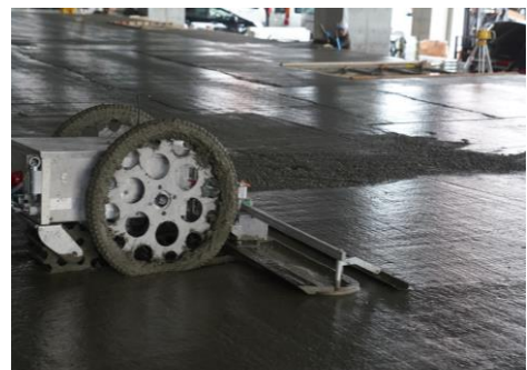
画像3 ひび割れ抑制のための締固め
