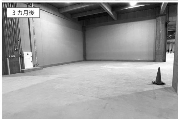
写真5 高耐久レベラー材によるレベリング工事
